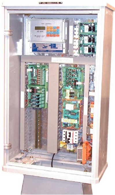
TIPICO QUADRO SINOTTICO DI SALA CONTROLLO (IMPIANTO S. BIAGIO PLATANI)
