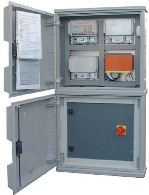
TIPICO QUADRO SINOTTICO DI SALA CONTROLLO (IMPIANTO S. BIAGIO PLATANI)
